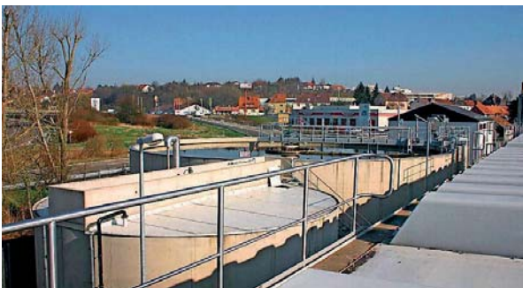
Die Kläranlage in St. Wendel.
